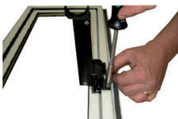
Læg vinduet med indersiden opad iht. billedet. Skrue håndtaget fast i karmdelen med en stjerneskruetrækker.
