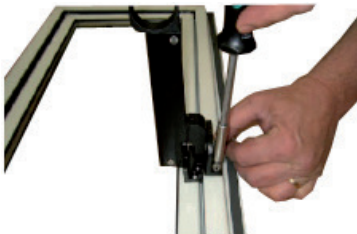
Lägg fönstret med insidan uppåt enligt bilden. Skruva fast handtaget i karmdelen med en stjärnskruvmejsel.
