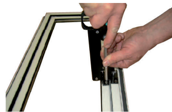
Kiinnitä kahva tämän jälkeen tuuletusikkunaan loppuilla ruuveilla.
